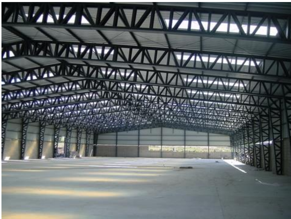
Figura 5–7 Modelo de Galpón donde se instalará la máquina trituradora
